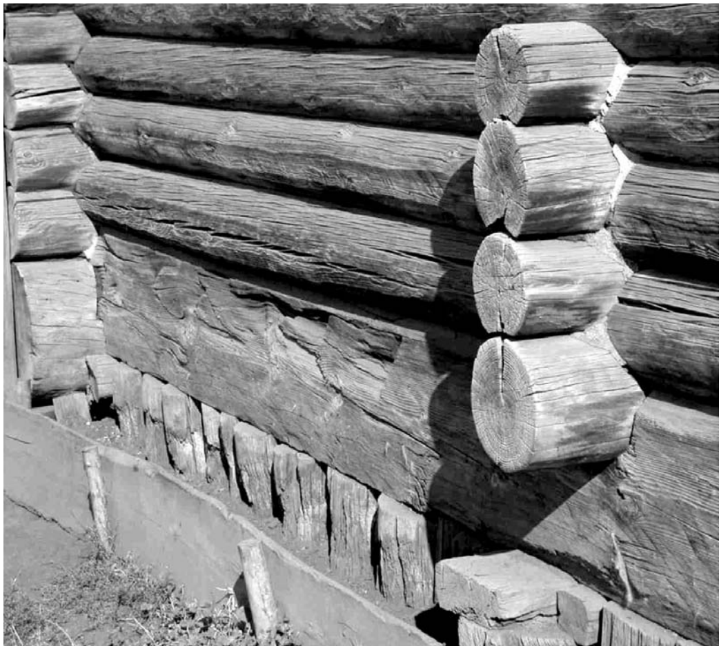
Рис. 1. Хозяйственная постройка на ЛССФ в с. Юрт-Акбалык Колыванского района Новосибирской области (фото А. П. Бородовского)
